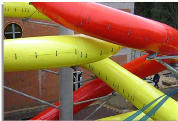
Для снижения теплоотдачи горок профиля Труба со стартом и финишем внутри здания и трассой снаружи него, возможно изготовление кожухов горок. В холодное время года они помогут уменьшить охлаждение горки при низких температурах и повысить комфортность катания. Элементы изготавливаются в любом цвете.
